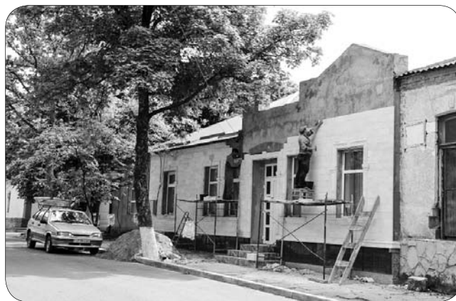
Fosta Școală de Învățători, Soroca. 2015
